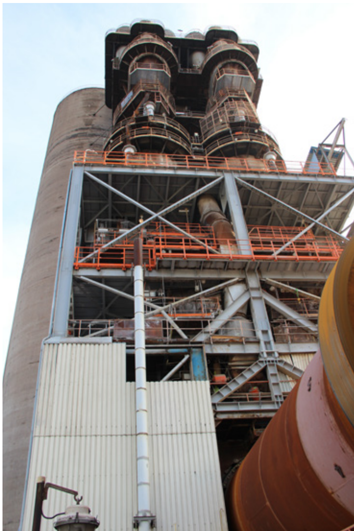
Nedílnou součástí zimních oprav je výměna opotřebovaných žáruvzdorných betonů ve výměníku tepla.
