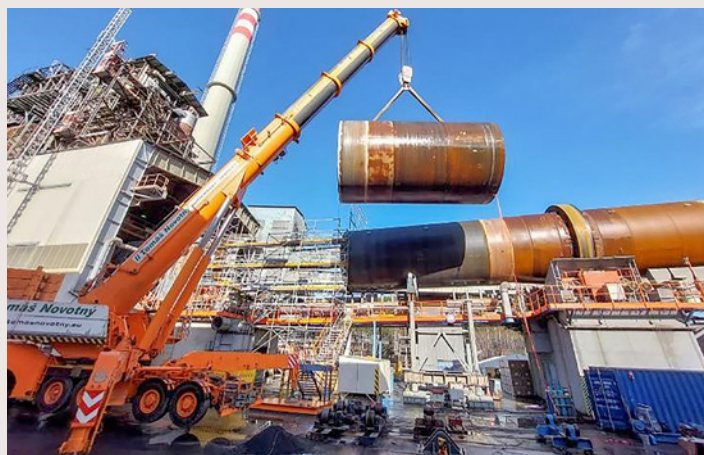
Během odstávky proběhla výměna části pláště rotační pece
